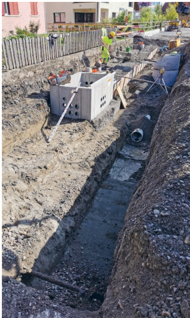
Sanierung der Fuchsgasse
