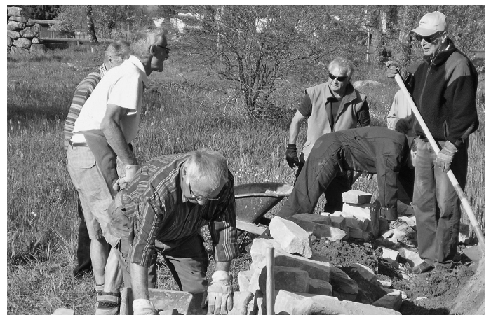
Silberwide – Bau einer Trockensteinmauer im Biotop beim Grundlochkanal
