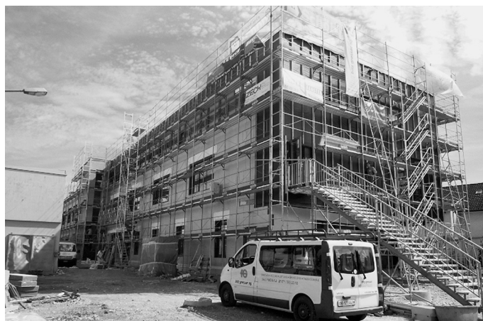
Stoffel während des Umbaus
