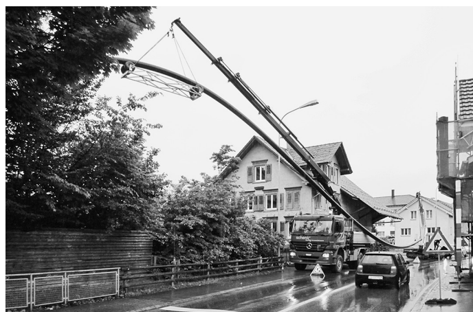
Einzug EV-Kabelschutzrohr
