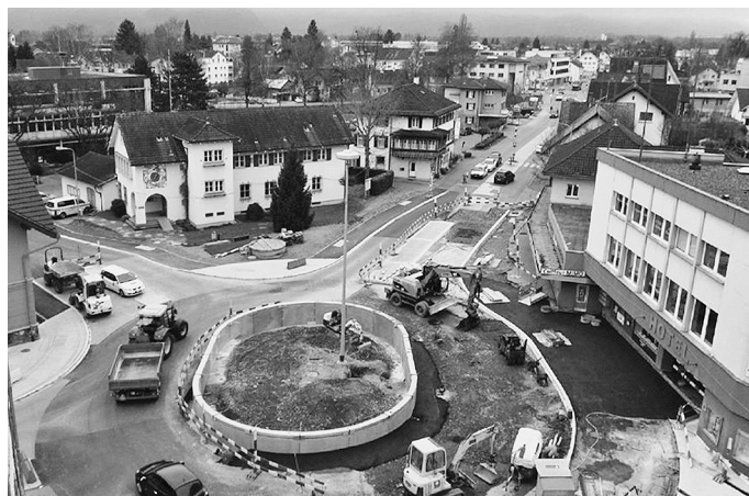
Bauarbeiten am Metropol-Kreisel
