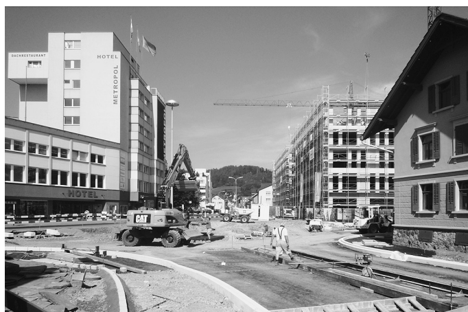
Strassenbau Kreuzung Neugasse-Bahnhofstrasse
