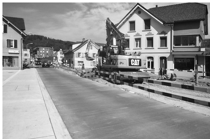
Neubau Kreuzung Zehntfeldstrasse-Bahnhofstrasse
