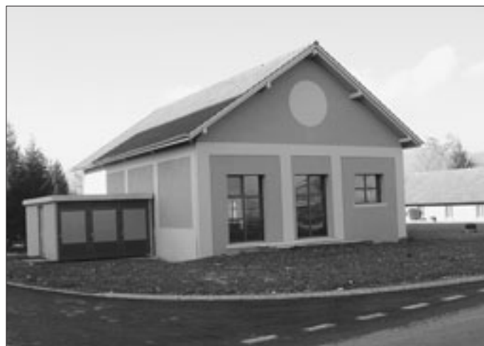
saniertes Pumpwerk-Gebäude im Viscose-Areal
