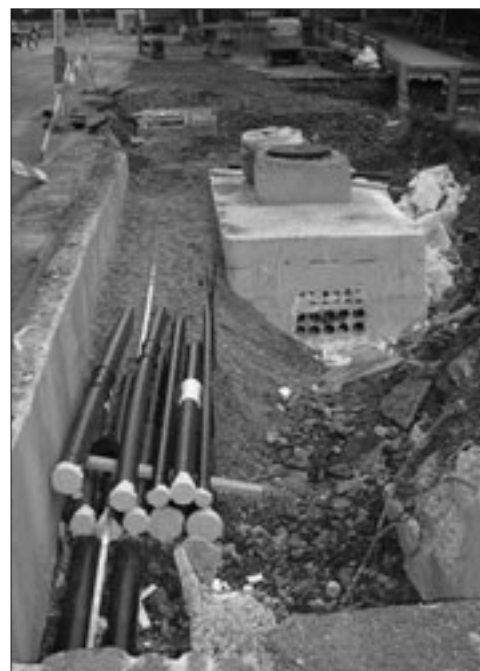
Kabelkanal beim Bau der Espenstrasse
