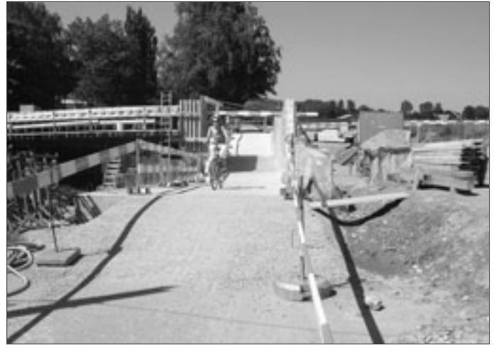
Radfahrer-Unterführung Espenstrasse / Lindenstrasse
