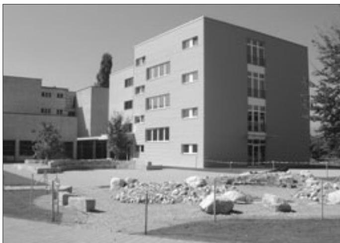
Erweiterungsbau Schulhaus Wyden
