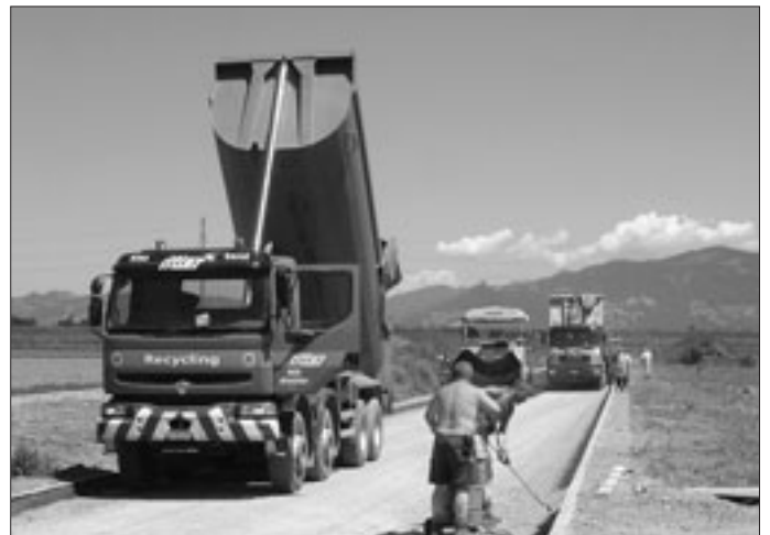
Einbau Deckbelag im Unterletten
