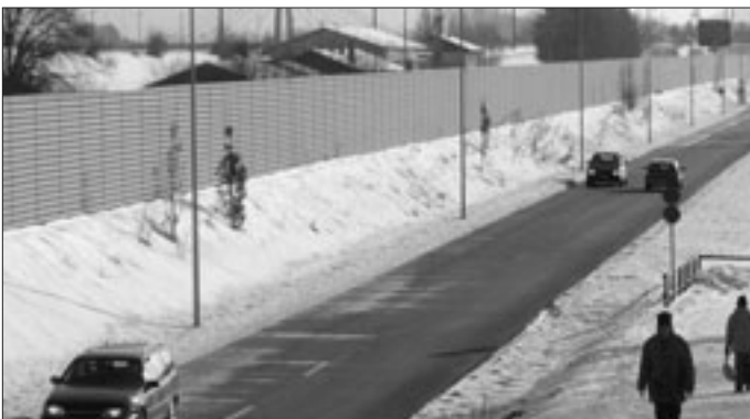
Espenstrasse im Bereich Lugwies
