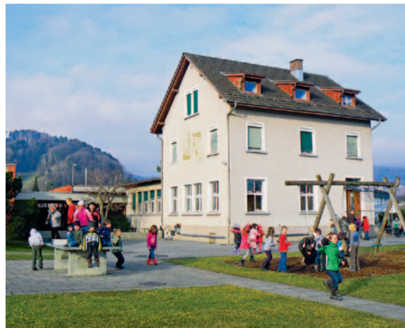
Das Schulhaus Nefenfeld weist erhebliche bauliche Mängel auf.
