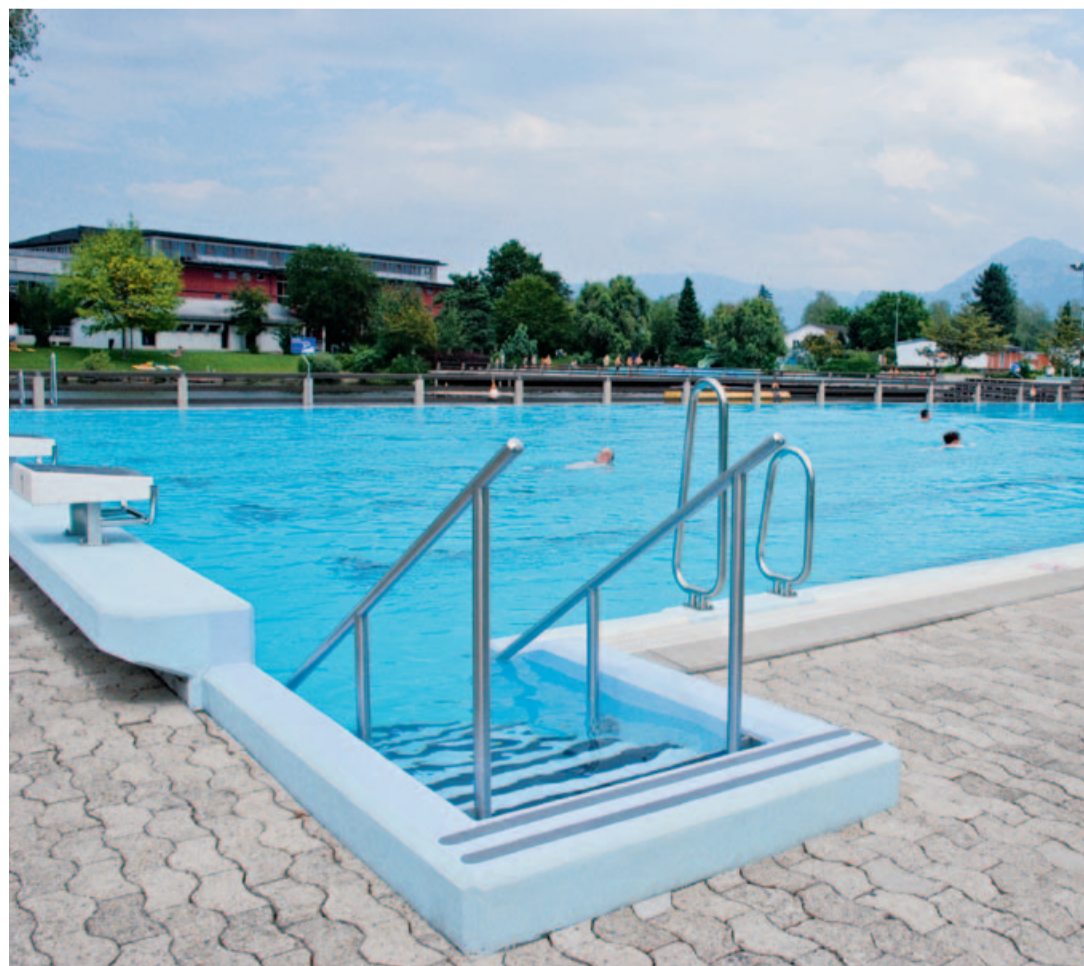
Der komfortable neue Einstieg ins sanierte Sportschwimmbecken.
