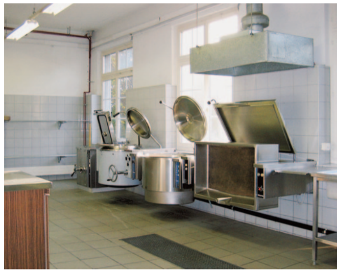
Ist-Zustand: Alte Militärküche im Erdgeschoss
