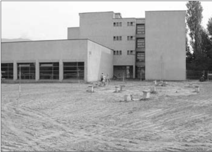
Erweiterung Schulhaus Wyden, Pfählungsarbeiten (August 2003)
