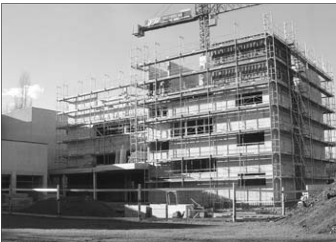
Erweiterung Schulhaus Wyden (November 2003)
