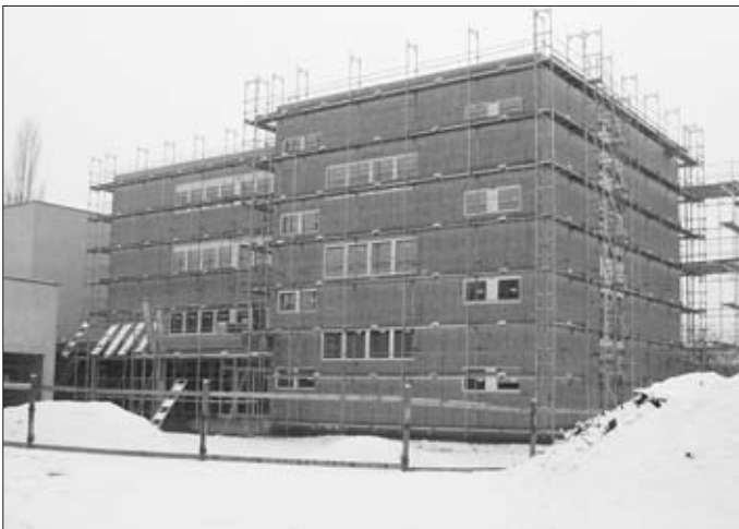
Erweiterung Schulhaus Wyden, Rohbau (Februar 2004)
