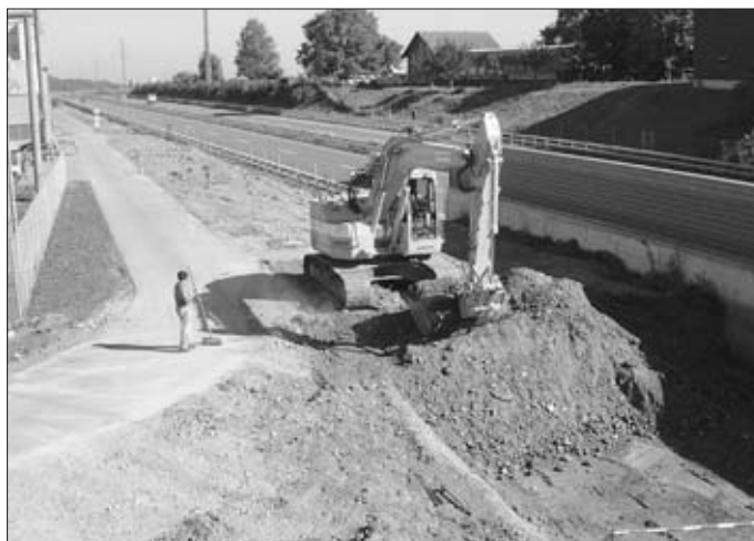
Espenstrasse: Teil Rheinstrasse bis SAK-Unterwerk
