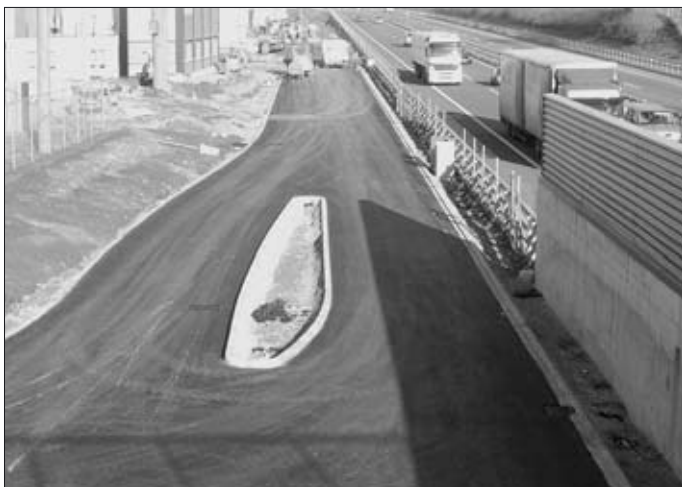
Espenstrasse: Teil Rheinstrasse bis SAK-Unterwerk
