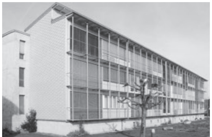
Zentrum Augiessen – Alterswohnungen Trattwies
