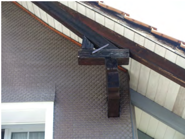
alte Flugsparrenkonstruktion
