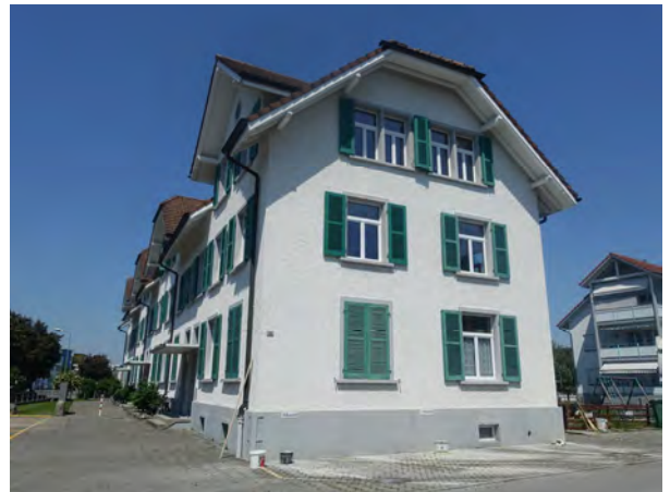
südliche Seitenfassade und Zugangplatz
