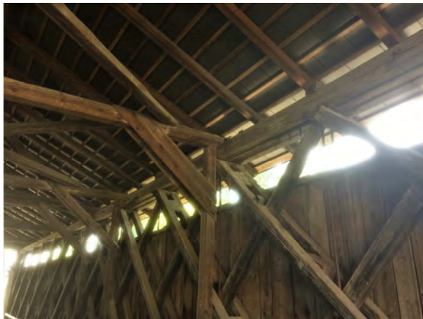
Innenansicht der Konstruktion
