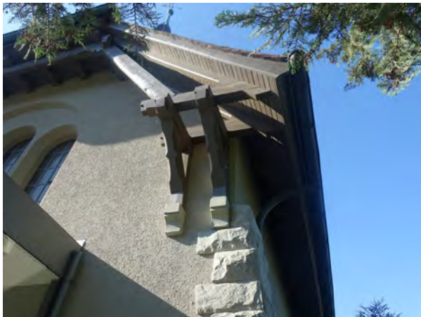
Dachgebälk u.a. mit doppelter Wandrähm, Sattelbalken, Bügen
