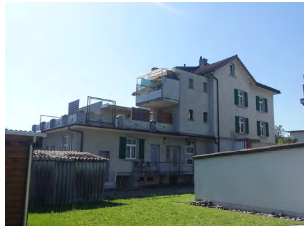
Gebäuderückseite mit Anbauten
