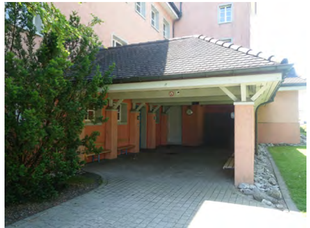
Offene Vorhalle vor dem Kindergarteneingang
