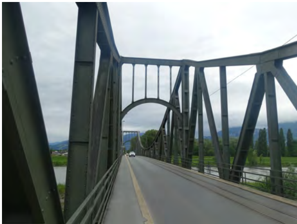
Verstrebungen der Pylone
