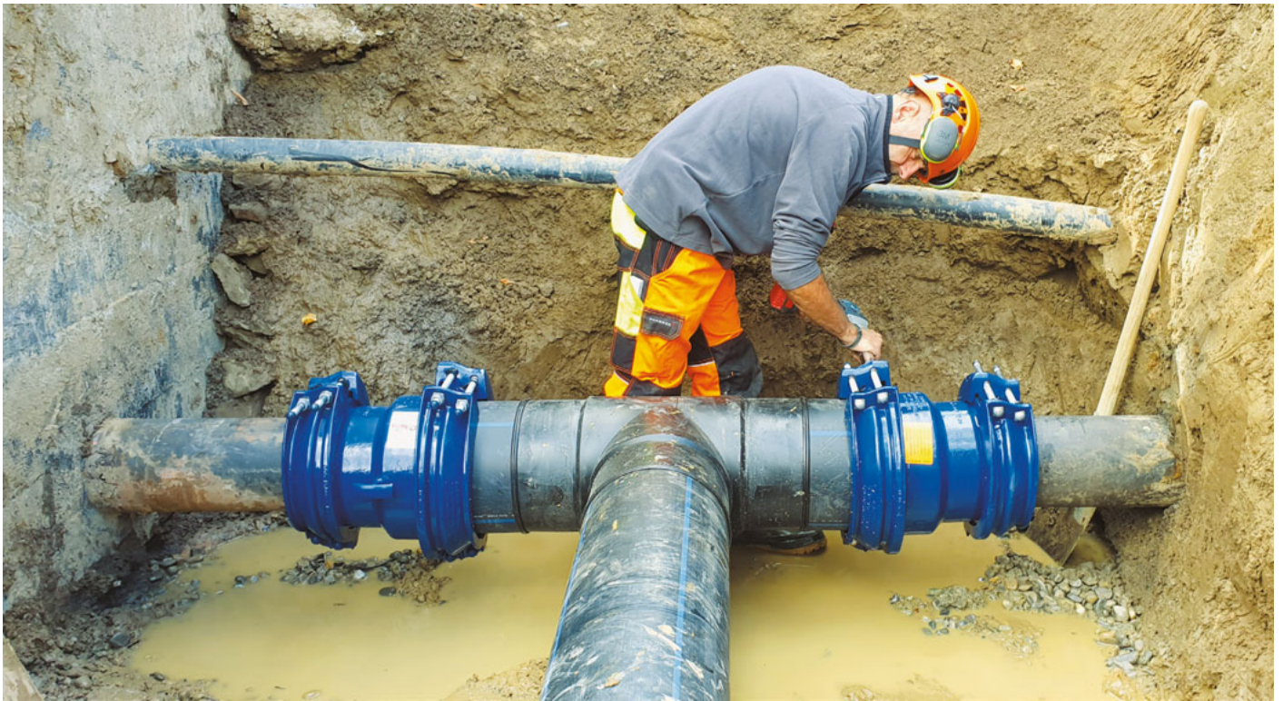
Leitungsumlegung WMR Grundstrasse, Rebstein
