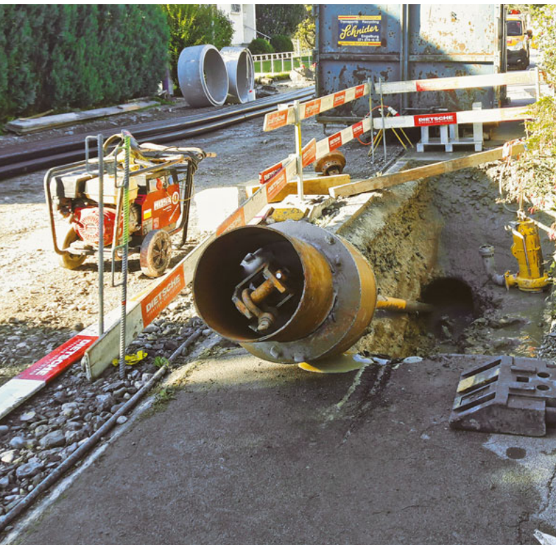
Schützenstrasse – gesteuerte Erdbohrung unter der Böschach hindurch
