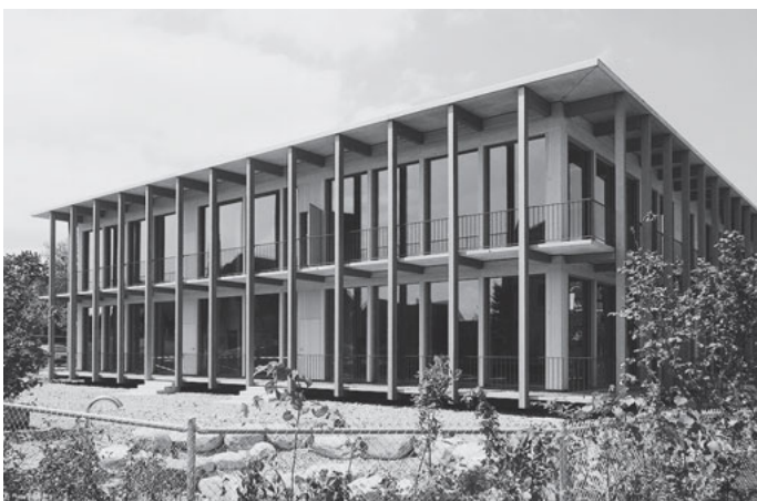
Das neue Schulhaus Schlatt
