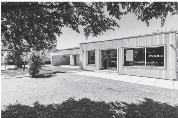
Sanierter Kindergarten Giren
