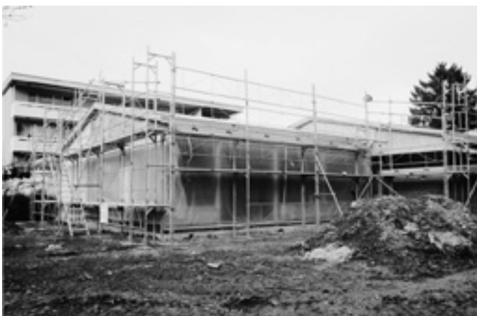
Sanierung Kindergarten Girlen
