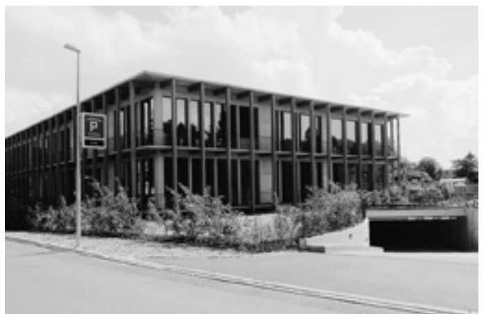
Schulhaus Schlatt mit Einfahrt in die Tiefgarage
