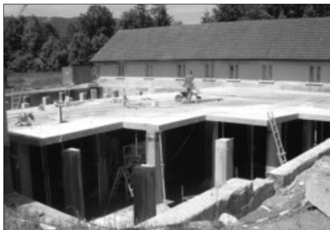
Sanierung Pumpwerk Viskose (ABRW)
