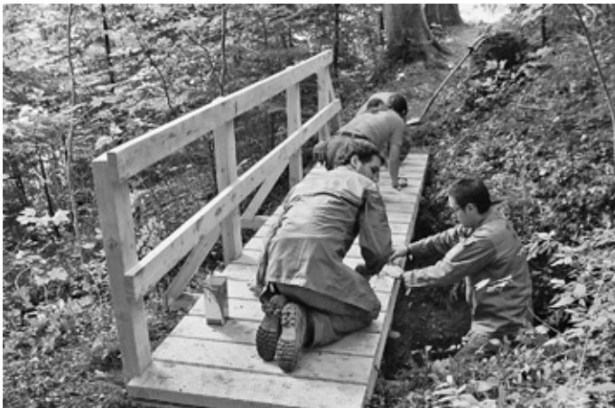
Neubau Brücke Försterwegli Balgacher Wald
