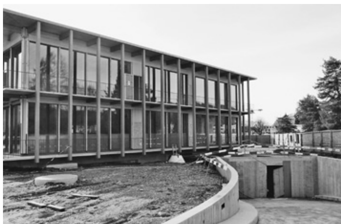
Rohbau mit Einfahrt in die Tiefgarage
