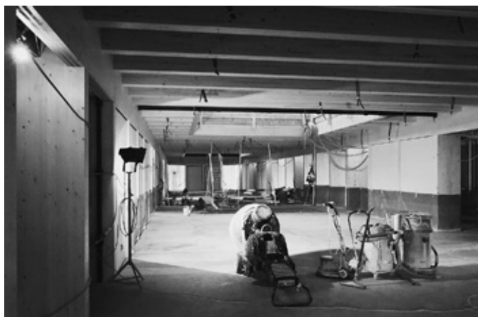
Innenausbau Schulhaus Schlatt
