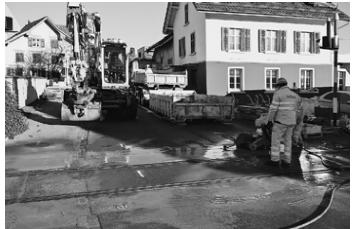
Vorbereitungsarbeiten für die Sanierung
