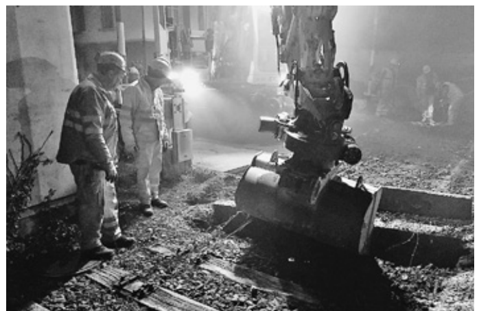
Sanierung des Geleises in der Nacht
