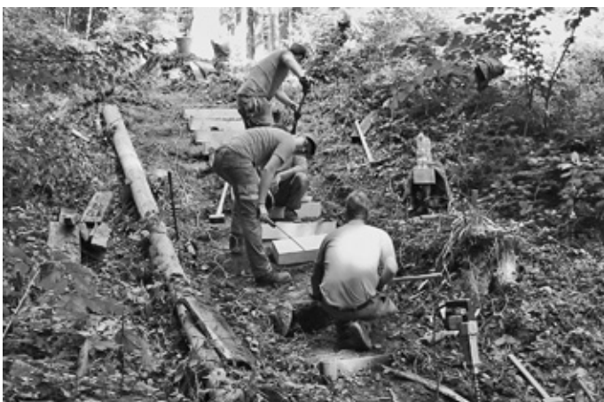
Neubau Treppe Walkingweg Balgacher Wald
