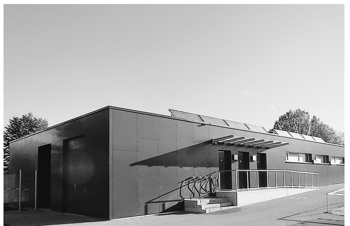
Garderobengebäude Sportplatz Aegeten
