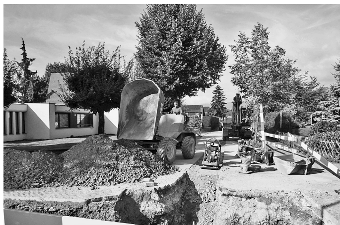
Sanierung Kreuzung Feldstrasse/Zinggenstrasse
