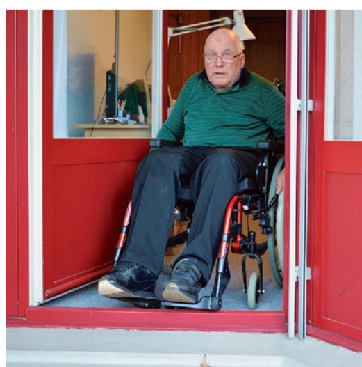
Die Schwelle beim Balkon ist zu hoch
