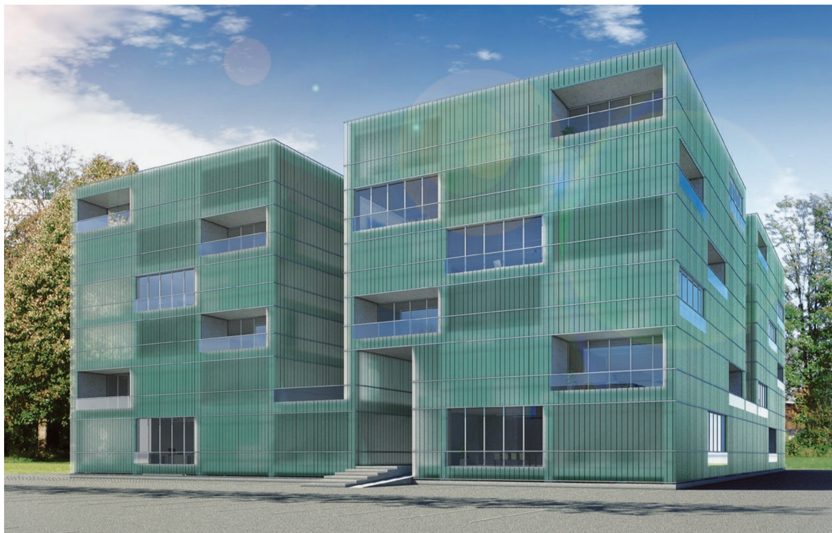
«Business Park No3 Widnau»: Die Profiliglassassade sorgt für lichtdurchflutete Räume. Bild: Baumschlagler Hutter Partners
